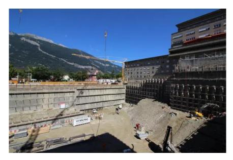
Il progetto di ampliamento della SUN per l'Ospedale Cantonale dei Grigioni prevedeva un nuovo edificio, compreso un garage sotterraneo. Lo scavo, profondo fino a 22 metri, era in parte direttamente adiacente all'edificio dei letti esistente. Inoltre, è stato scavato un canale di alimentazione sotto gli edifici esistenti della risonanza magnetica e della sala operatoria.
