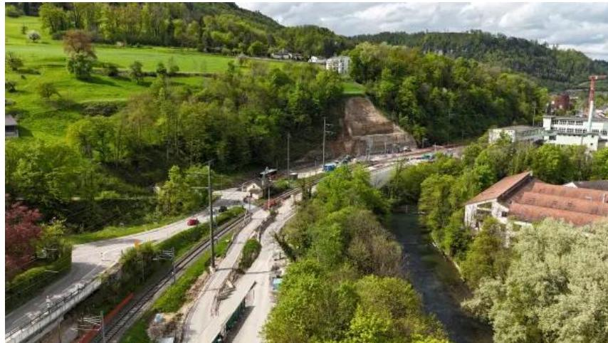
La section à voie unique entre Laufen et Aesch BL est en cours de doublement sur environ 4,7 km entre Duggingen et Grellingen afin d'augmenter la capacité et de permettre davantage de liaisons ferroviaires. Le projet comprend des travaux de génie civil, l'extension de quais et l'adaptation de passages à niveau.
