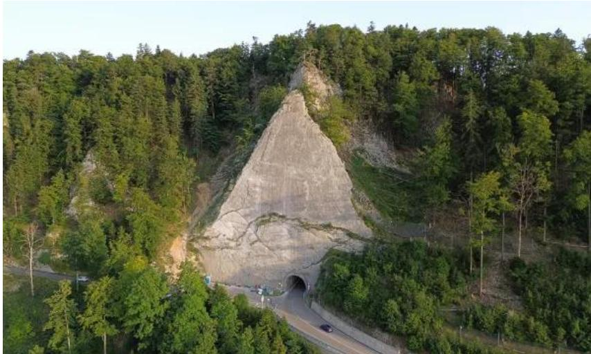
Zur Überwachung der 70 Meter hohen Gesteinsplatte über dem Zingelentunnel (SO) wurde die Terradata vom Kanton Solothurn mit Vermessungs- und Monitoringaufgaben beauftragt. Ziel des Projekts ist es, Bewegungen der Gesteinsschuppe zuverlässig zu erfassen und so die Sicherheit der Strasseninfrastruktur nachhaltig zu gewährleisten. Die Umsetzung des Projekts erfolgte in mehreren sorgfältig abgestimmten Schritten.
