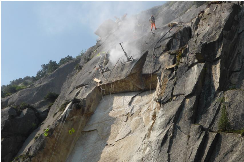
Am 20. Mai 2015 ging in der Schöllenenschlucht zwischen Göschenen und Andermatt ein grosser Felssturz im Bereich einer Strassengalerie nieder, wodurch die Strassenverbindung durch die Schlucht aus Sicherheitsgründen geschlossen werden musste. Oberhalb der Strasse hatten sich 900 Kubikmeter Fels gelöst und beschädigten teilweise die Strassengalerie. Weitere 200 Kubikmeter Fels drohten sich zu lösen und gefährdeten die Aufräum- und Felssicherungsmaßnahmen.
